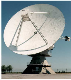
Fig. 6. Antena de RADAR en Chilbolton (UK) con aplicaciones meteorológicas.
